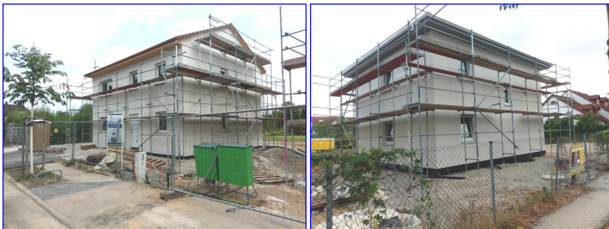
Bautenstand Stadvilla ZOSSEN (links) und Stadvilla WERDER (rechts) am 15.08.2018
